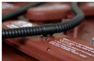
Tubería sin abrazaderas
