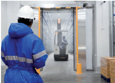
Almacenamiento en frío / Aplicaciones en exteriores
